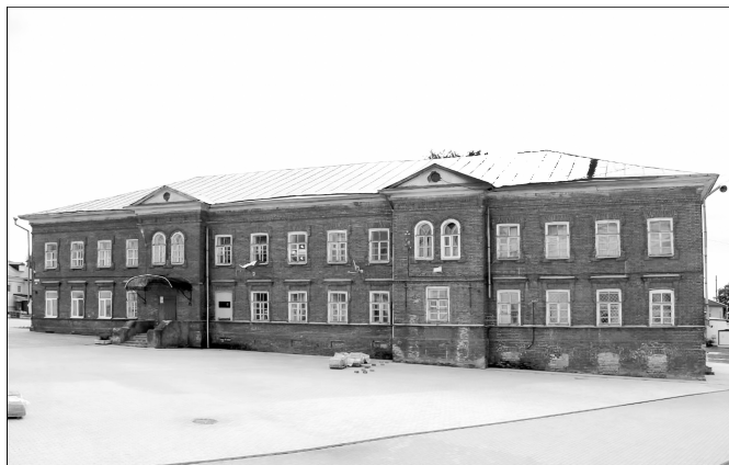
Здание средней школы №2 Угличского района
