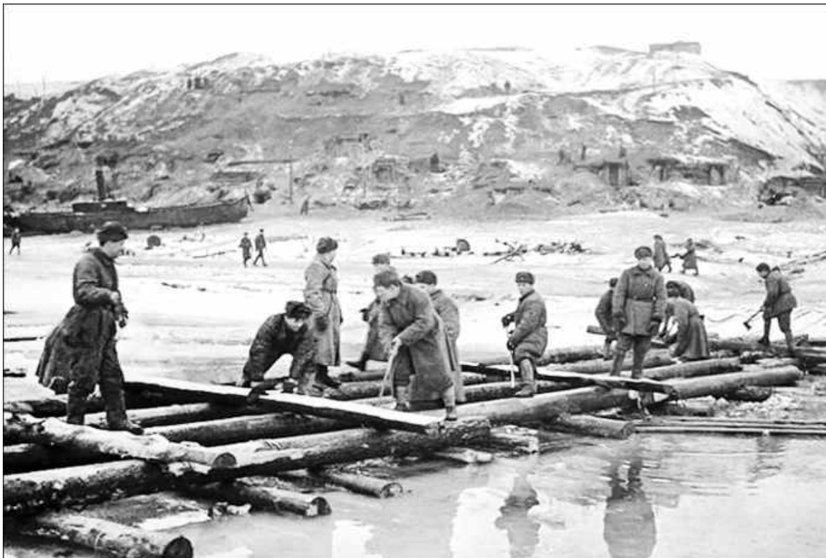
Работа инженерно-сапёрных частей по наведению переправы. Из сети интернет
