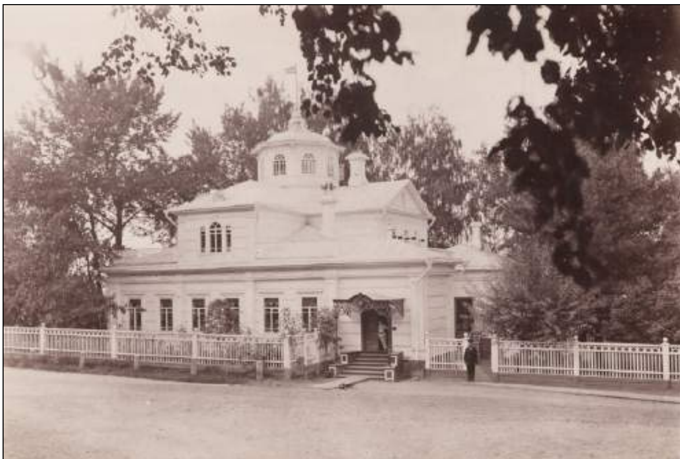
Изо Р-45. Большой дом Цуриковых-Поповых, 1910-е, (АШ).
