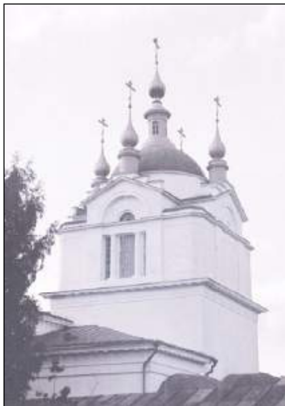
Изо 7–23. Вознесенская церковь в г. Воскресенске 87 , 1910-е ?
