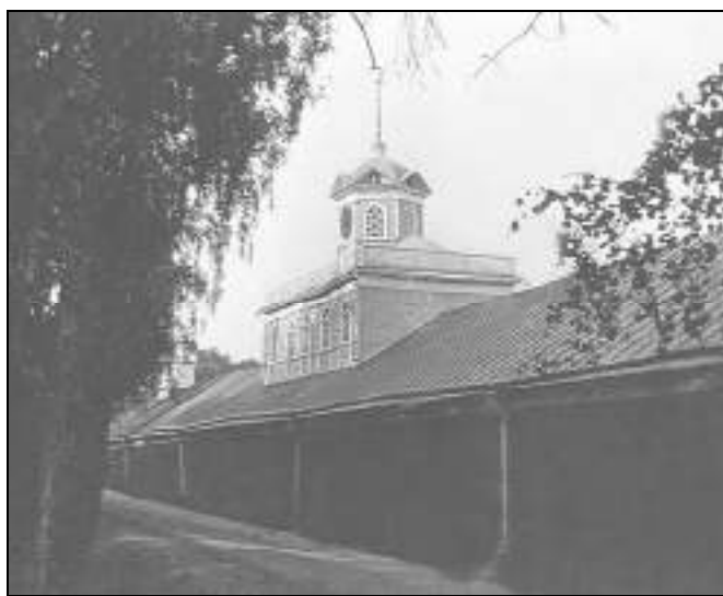
Изо 3–17. Башенка с часами в ограде Ивановской фабрики, (АШ).
