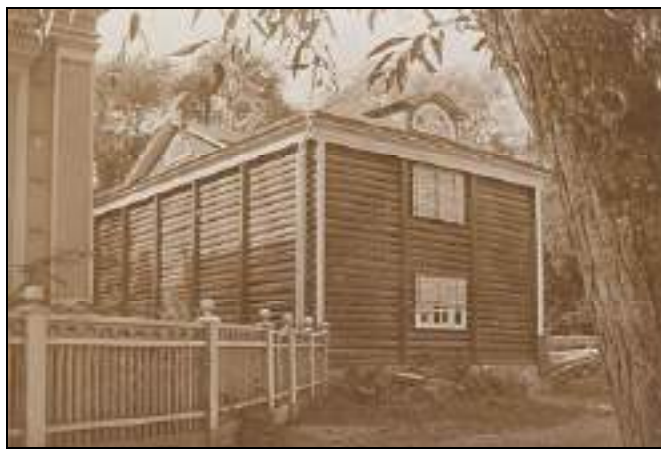
Изо Р-31. Здание мельницы, (АШ).
