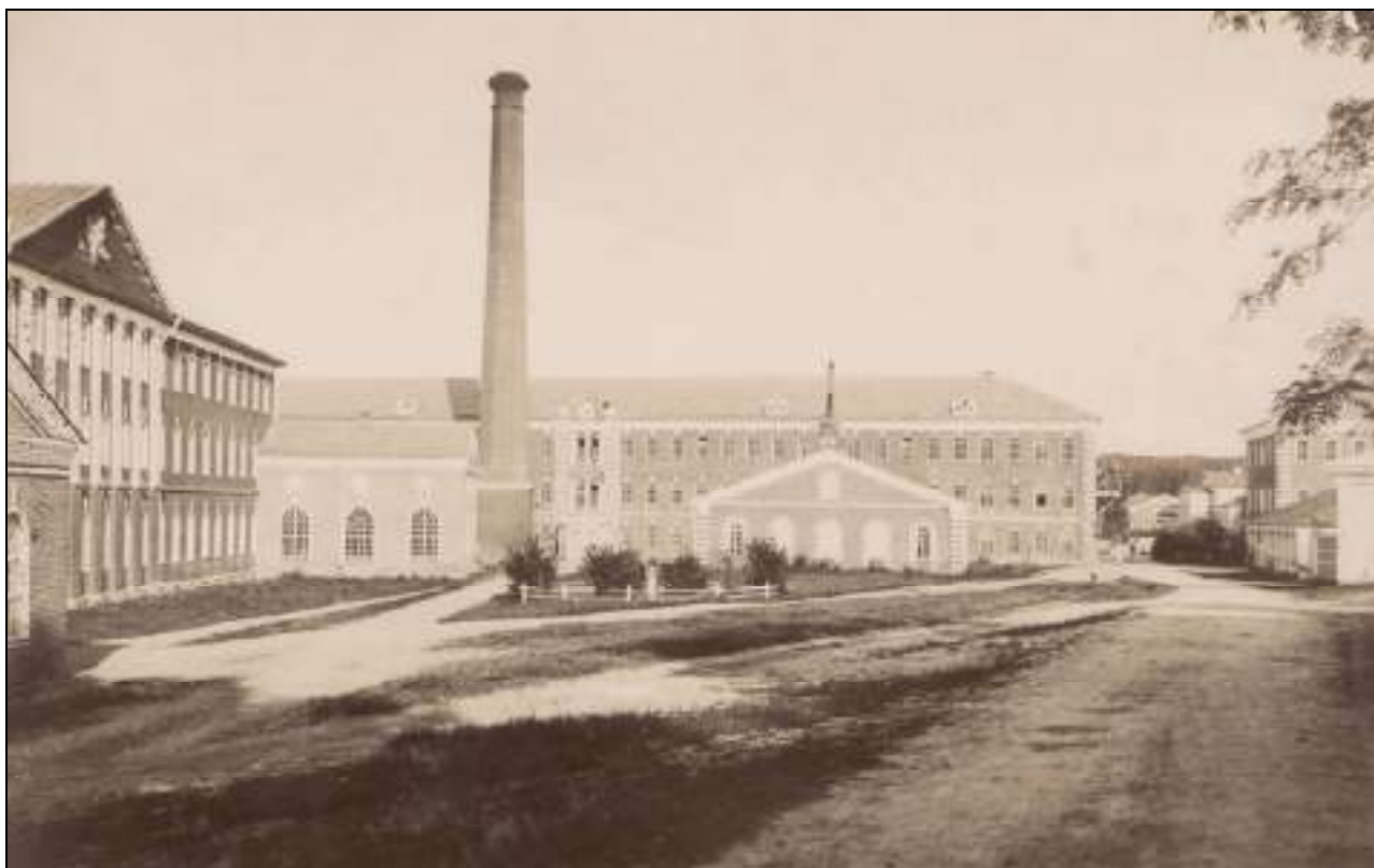
Изо Р–20. Главный двор Ивановской фабрики, 1910-е, (АШ).
